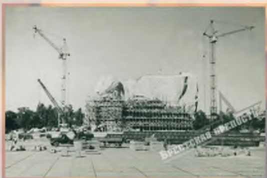
Главный монумент в строительных лесах. 1971 г. Фото: МК «Брестская крепость-герой»
